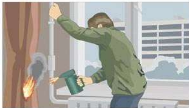
Отогревание замёрзших труб стальными лампами и факелами
